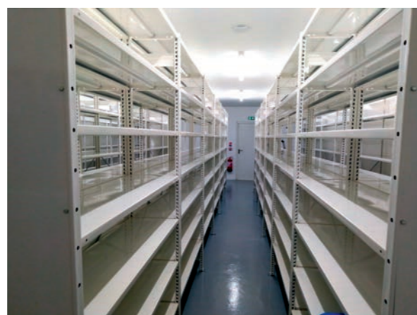
Salle des archives de la Mairie de Rocbaron. Récemment, la commune a créé un service dédié à cette activité.
